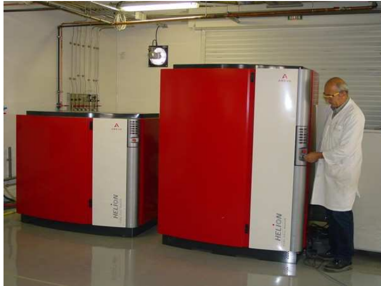
Générateur stationnaire de secours de 20 kW Hélion Hydrogen Power - 2005
